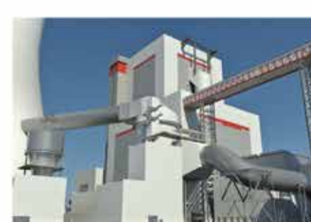
PGE GIEK S.A. Elektrownia Turów
